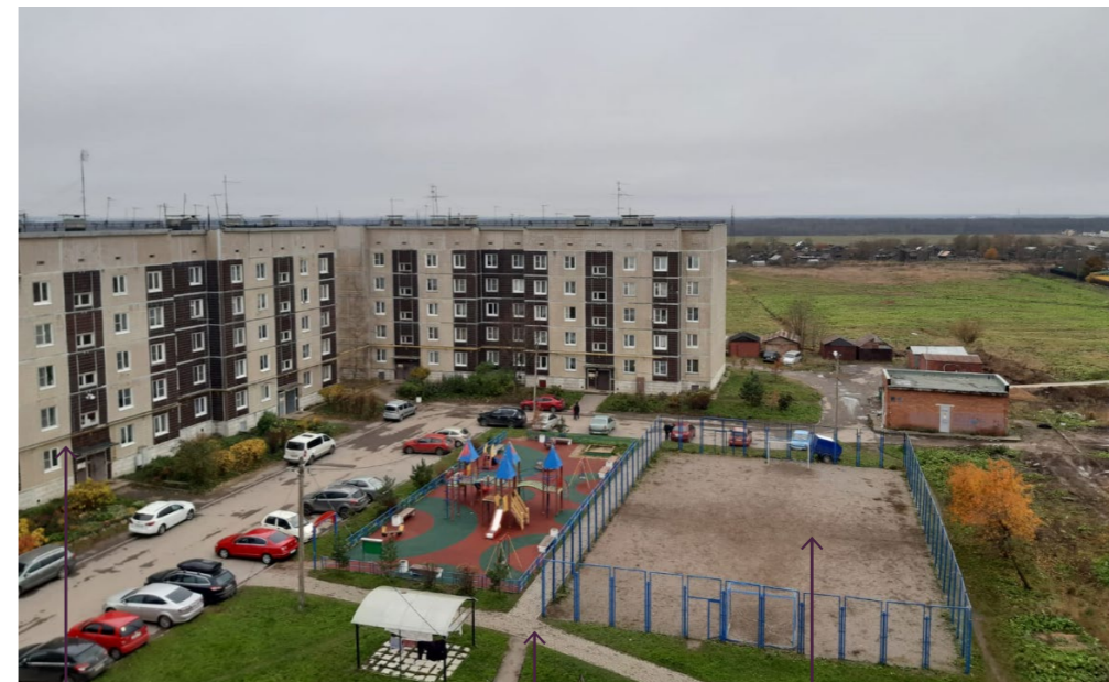
13 дом по ул Шоссейная Дорожка к остановке проходит по границе проектирования Старая футбольная площадка
